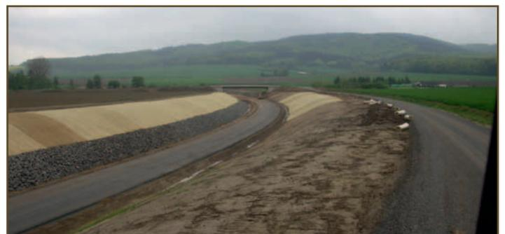
**4.2 Böschungssicherung mit Erosionsschutzmatten und vorheriger kundenspezifischer Saataufbringung**
