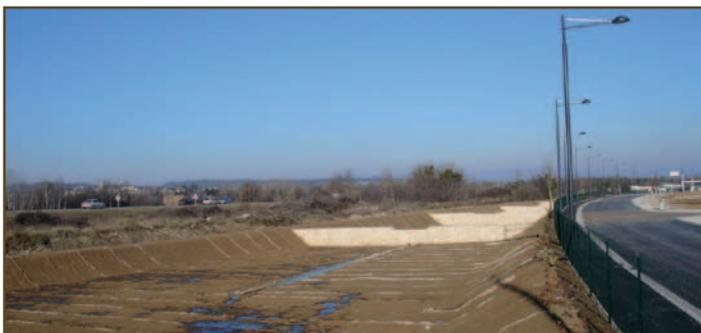
9.3 GRÜNFIX Erosionsschutzmatte Typ 6J
