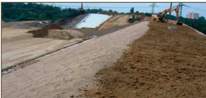
16.2 Verlegung von Jutegewebe „SOIL Saver“ an einer Böschung 1 : 1,5
