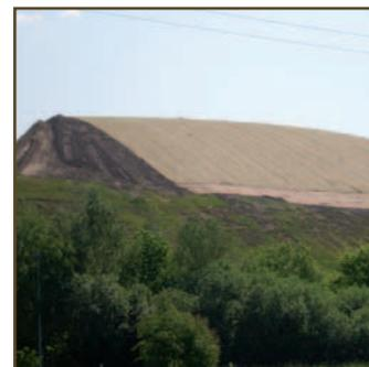
8.5 GRÜNFIX **Erosionsschuttmatte** Typ 5 im Deponiebau
