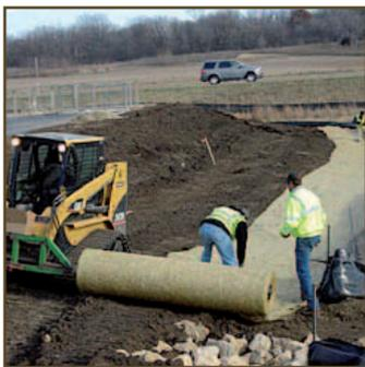
8.1 Individuelle Rollenlängen der GRÜNFIX **Erosionsschuttmatten** für eine schnellstmögliche Verlegung
