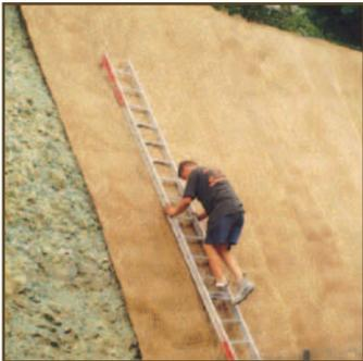
12.1 Verlegung von GRÜNFIX **Drahtmatten Typ 5D** an einer 65° Böschung
