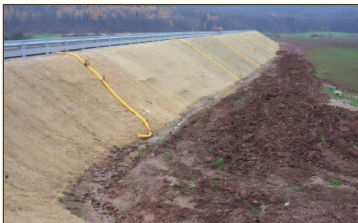
26.5 Böschungssicherung mit GRÜNFIX **Typ 4** und gleichzeitigem Abfluss des Strassenoberflächenwasser über Dränagerohre
